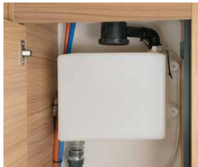
+ Goed beschermd tegen vorst: dankzij een binnenliggende afvalwatertank (optioneel)
