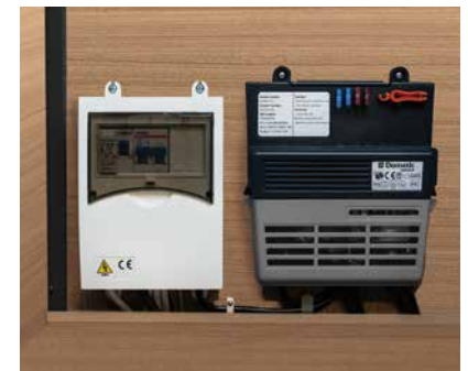
+ 12 volt stroomvoorziening met LED indicator bij een defecte zekering
